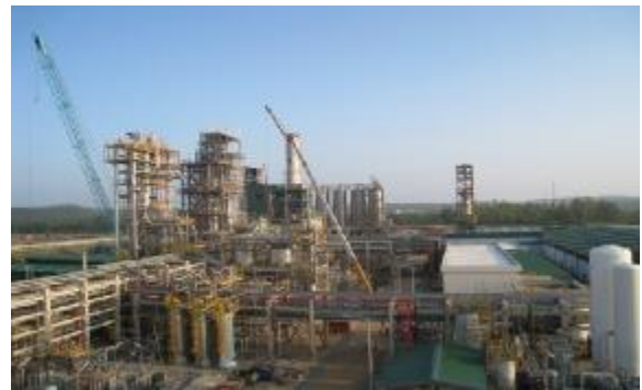
Công trình Nhà máy Nhựa Polypropylene Dung Quất
