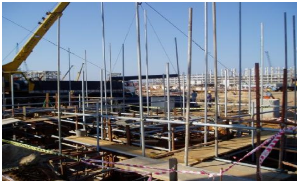
Ảnh : Dự án Nhà máy sản xuất bao bì Polypropylene
